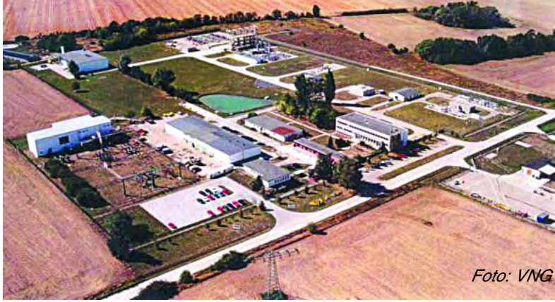
Links: Luftaufnahme des Standortes Ketzin
